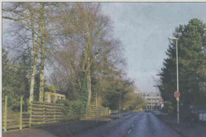
Bald Allee? Der Uhlhornsweg vom Quellenweg aus betrachtet.
