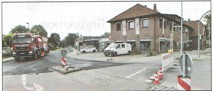
Neue Asphaltdecke für den Hartenscher Damm.
